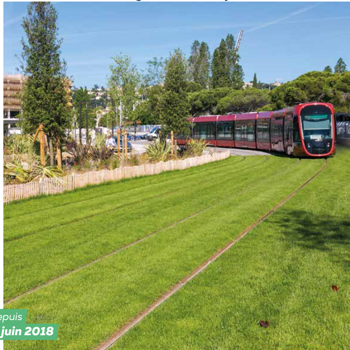
Ligne 2 de tramway
