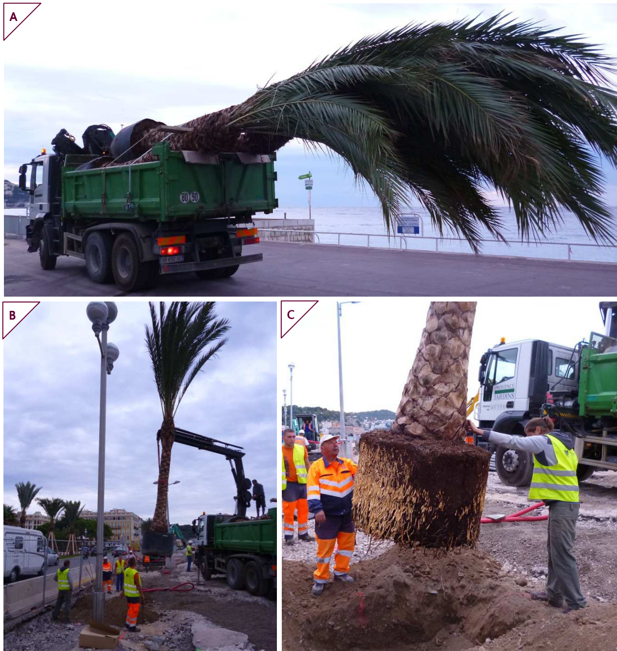
Figure 28. Transplantation de palmiers dattiers ( Phoenix dactylifera ) de grande dimension sur le Trottoir Sud de la Promenade des Anglais, Nice.
