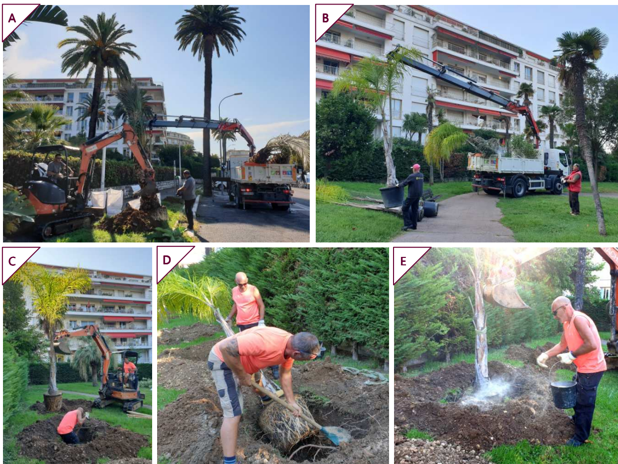
Figure 21. Plantation d'un palmier au Parc Vigier, Nice. (A, B) Manutention des palmiers à l'aide d'un camion-grue et d'un homme de pied. (C) Manutention à la minipelle. (D) Reprise des racines avant plantation. (E) Ajout de stimulant racinaire.
