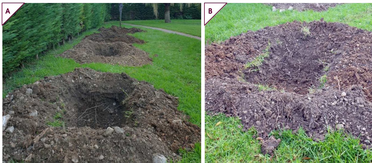
Figure 19. (A, B) Réalisation de fosses de plantations rectangulaires avec parois déliées et fond de forme décompacté – Parc Vigier, Nice.
