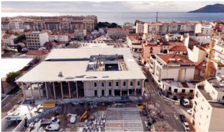
La construction en cours à Bocca centre de la Halle du marché et des services publics s'accompagnera de la réalisation d'un grand jardin public de 4000 m 2 au nord du bâtiment.
