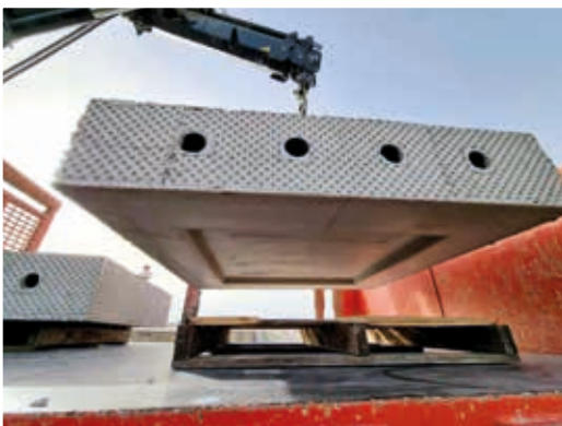
Les nouveaux équipements sont composés de béton désactivé aux surfaces rugueuses et petites cavités pour abriter la faune et la flore.
