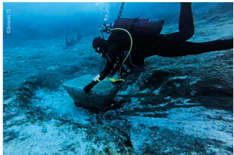
Les plongeurs ont procédé au remplacement des quatorze corps-morts restant en janvier dernier.
